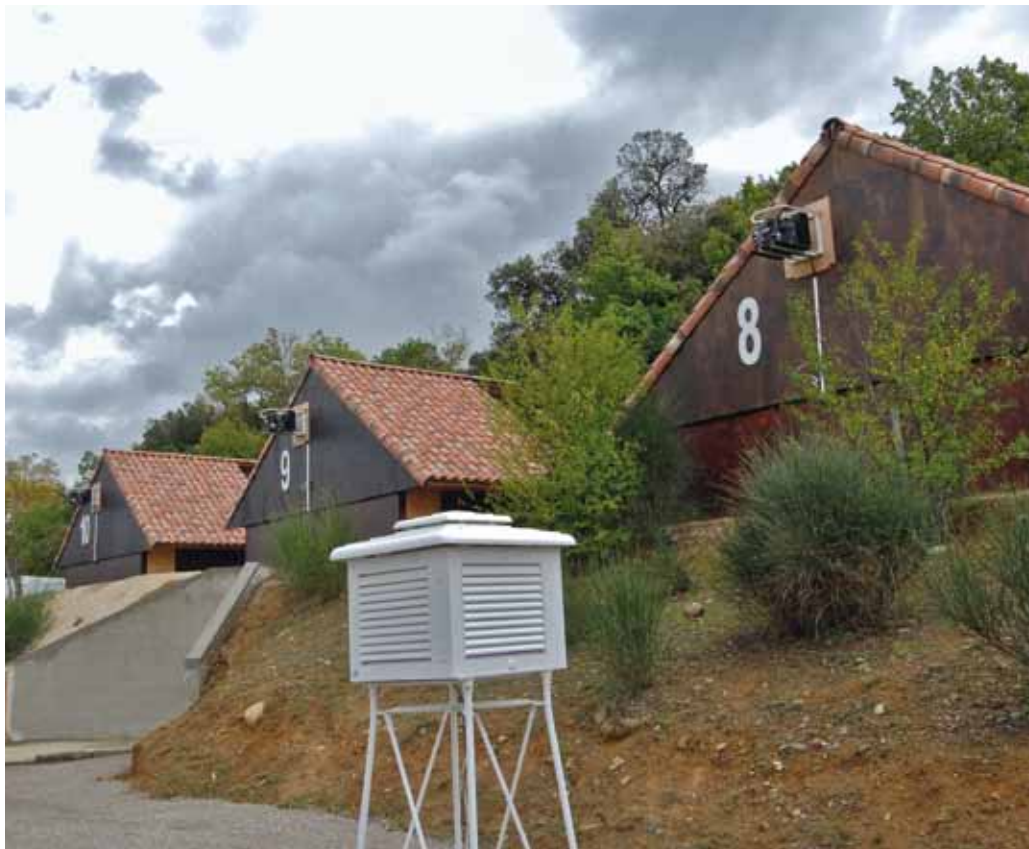
Ejemplos de edificios de ensayos in situ .
